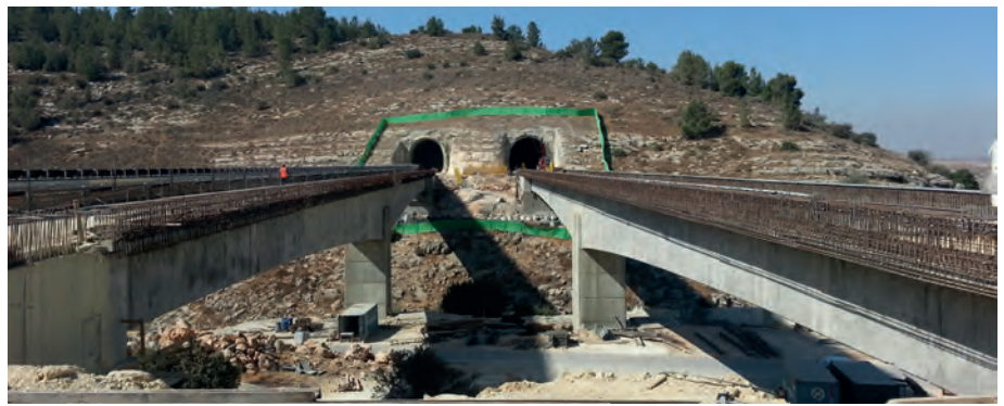
Abb. 5: Brücke 8 mit Blick auf Portal von Tunnel 2
